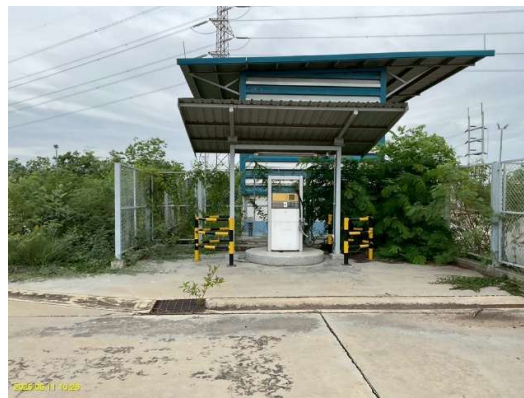
แท่นจ่ายน้ำมันเชื้อเพลิงสำหรับรถยนต์ที่ใช้ภายในสถานี
