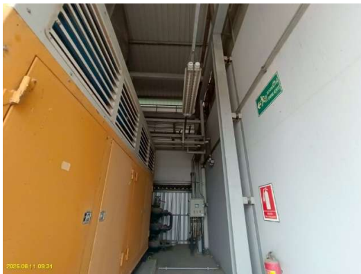
ระบบไฟฟ้าที่ใช้ภายในสถานีก๊าซธรรมชาติหลักเป็นชนิดป้องกันการระเบิด (Explosion Proof) (ต่อ)
