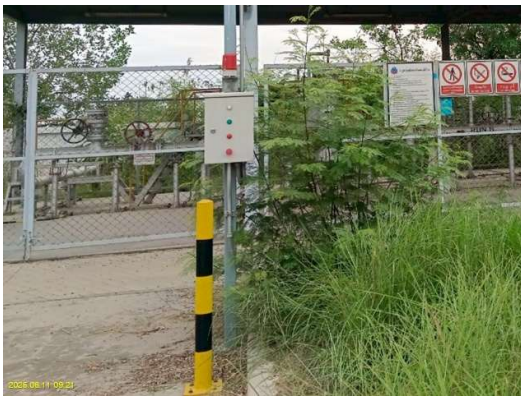
ติดตั้งระบบสัญญาณไฟแจ้งเตือนเมื่อเกิดเหตุฉุกเฉิน
