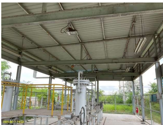
ระบบไฟฟ้าที่ใช้ภายในสถานีก๊าซธรรมชาติหลักเป็นชนิดป้องกันการระเบิด (Explosion Proof)
